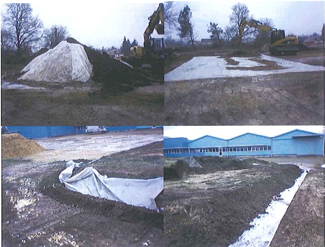
Figure 16 : reportage photographique de la mise en place du landfarming
