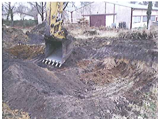
Figure 13 : Curage au niveau de l'ancien stockage de fioul
