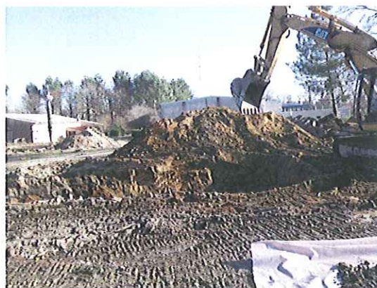
Figure 8 : Curage de l'ancien bac de trempage
