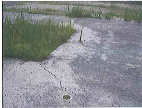
Figure 7 : Photo de la dalle béton avant démolition
