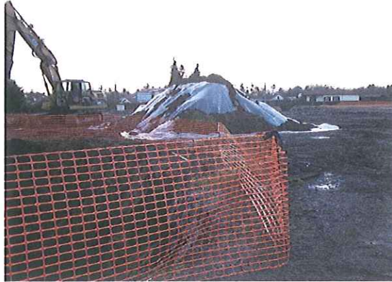
Figure 10 : stockage provisoire PCP
